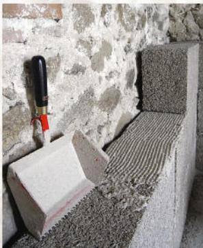
pose de blocs de chanvre en isolation intérieure d'un mur en pierres
